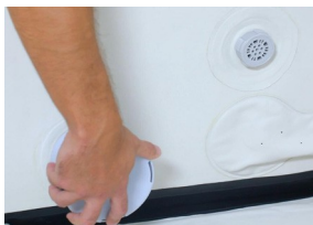
13) Vložte filtrační vložku do držáku a přišroubujte ji k dolní sací části uvnitř nádrže.
