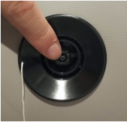
Přímo stlačte pružinu ventilu, aby se vypustil vzduch.
