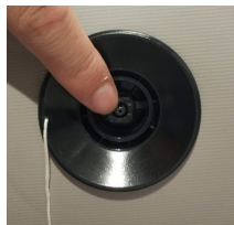
3) Zkontrolujte pružinu uvnitř ventilu v horní poloze.
