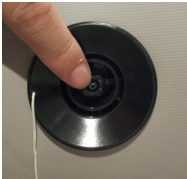
Stiskněte přímo vnitřní pružinu klapky, aby se vypustil vzduch.
